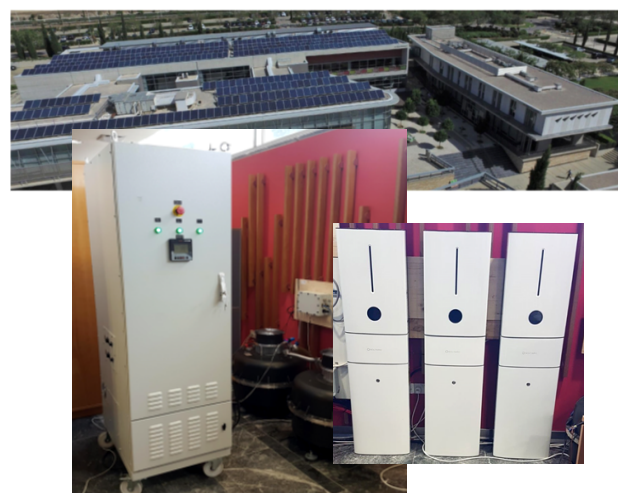
Πιλοτικό 2: Μπαταρία και σύστημα αποθήκευσης σφονδύλου στο Κέντρο Αριστείας ΚΟΙΟΣ του Πανεπιστημίου Κύπρου
