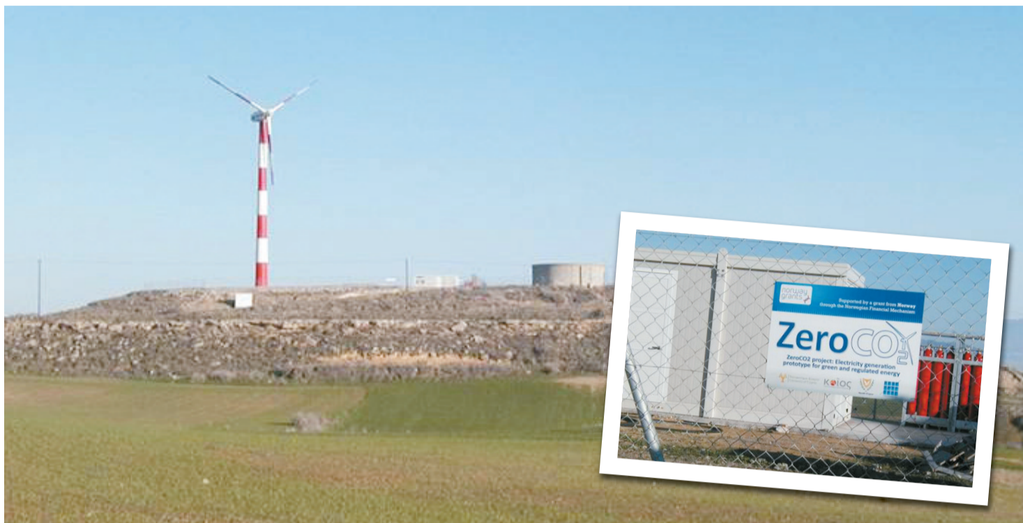
Η ΑΙΟΛΙΚΗ ανεμογεννήτρια ονομαστικής ισχύος 225Kw, που βρίσκεται εγκατεστημένη στο Γέρι, έχει συνδεθεί με το δίκτυο της ΑΗΚ.
